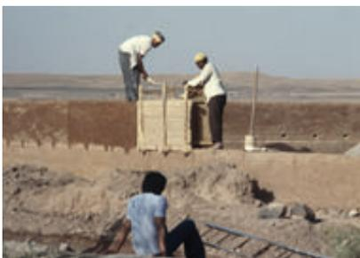
Mise en œuvre d'un mur en pisé de terre crue entre des planches en bois au Maroc. Photo A.-S. Cléménçon.
