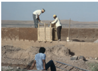
Mise en œuvre d'un mur en pisé de terre crue entre des planches en bois au Maroc. Photo A.-S. Cléménçon 2017
