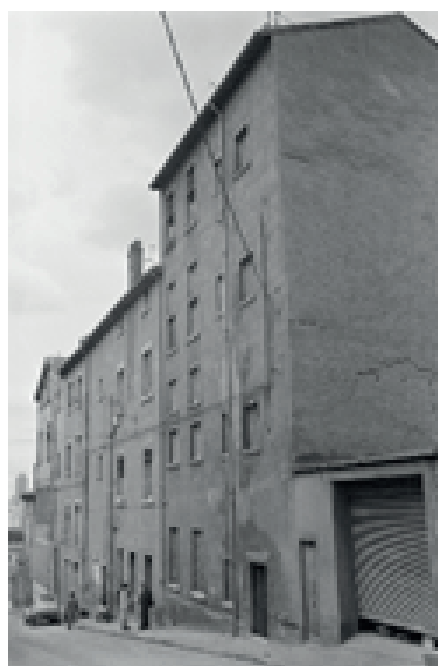
Premier inventaire de l'architecture de terre à Lyon en 1981 par A.-S. Cléménçon et D. Bertin. Un immeuble de grande hauteur dont le mur aveugle à l'enduit abimé révèle le pisé (à droite). Photo A.-S. Cléménçon
