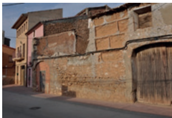
Bâtiments construits en pisé, Pérou, 1981. Photo A.-S. Cléménçon
