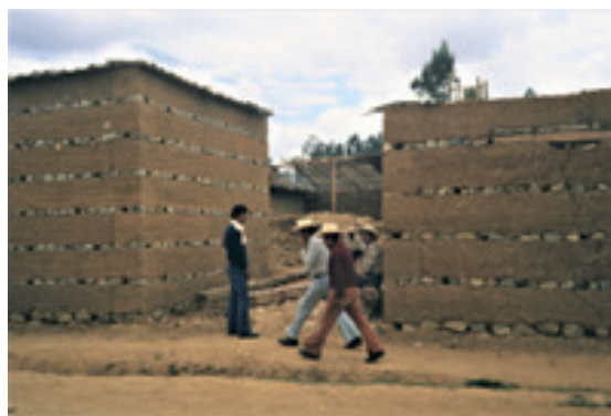
Bâtiments construits en pisé, Pérou, 1981. Photo A.-S. Cléménçon
